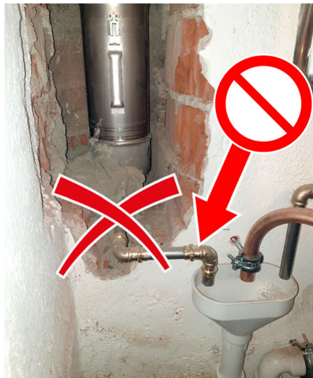
Fig. 7-2: Version interdite de l'écoulement de condensat
