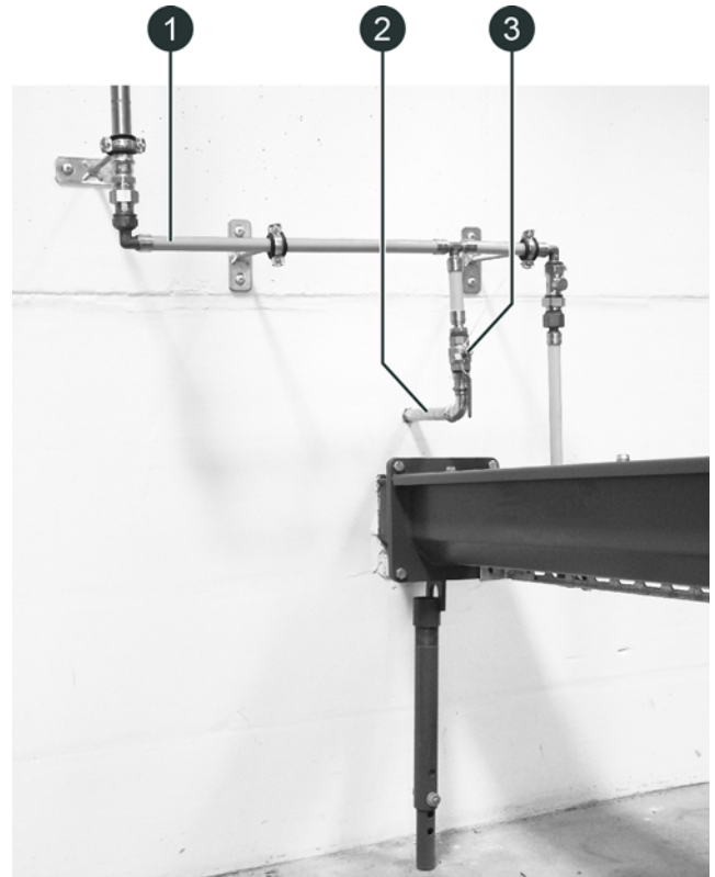
Fig. 6-7: Dispositif d'extinction à déclenchement manuel (HLE)
